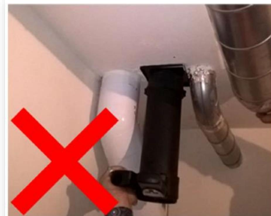
Meten zonder conus is in elk geval niet correct. Eventueel is het wel mogelijk om met de techniek uit §10 het debiet van dit ventiel te meten.
